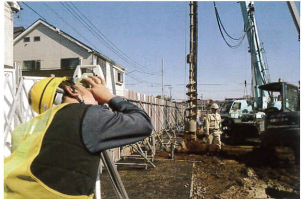
写真-1 掘削時の光波測量の状況例
