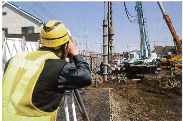
写真-2 杭建込み時の光波測量の状況例
